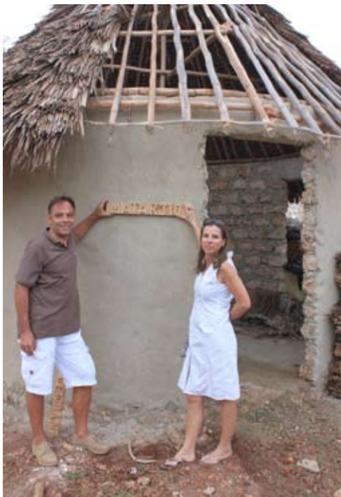
„Unsere“ Hütte Matarjo (Hoffnung) im Rohbau
