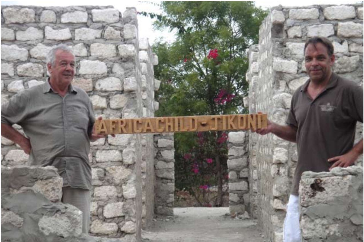
Africachild-Jikoni (Küche und Waschräume) im Rohbau
